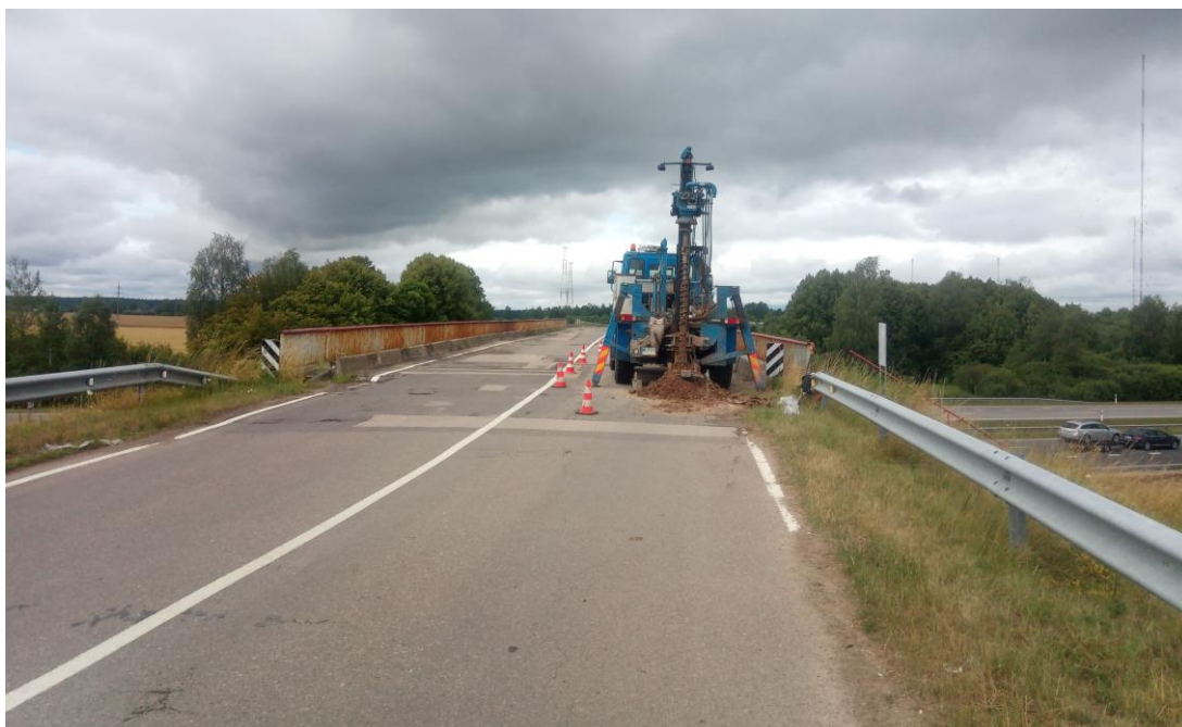
pav. Lauko darbai ties gręžiniu Gr.1
